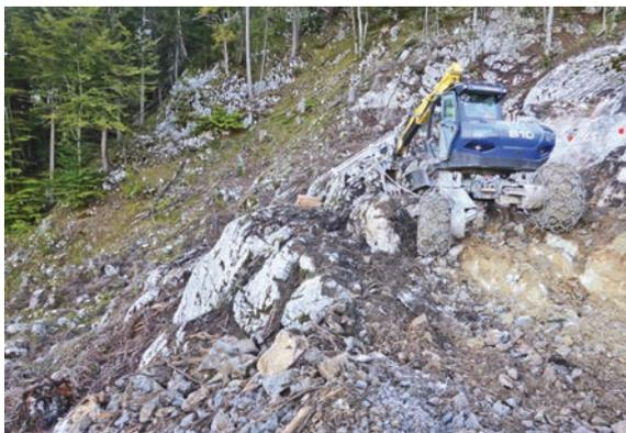
*Errichtung der Zufahrt in steilem Gelände mit Schreitbagger und Sprengabtrag.*
